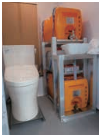
(写真左) 活性炭を用いた3層のろ過装置と洗浄水タンク (写真右) 暖房便座も備え快適なウォッシュレット付き水洗トイレ
